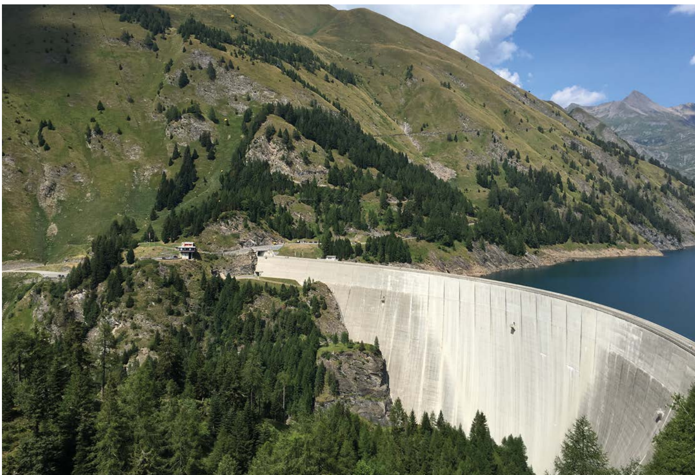
Diga del Luzzone
